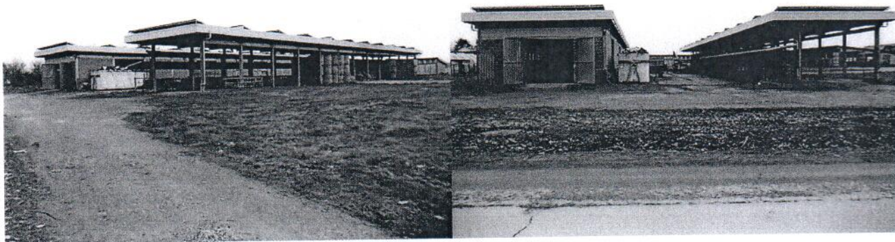
Fig. 1 – fabbricati relativi all'impianto da 97,02 kWp
